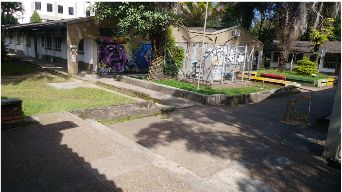
Detalle de subestación eléctrica y bloque No. 12 Universidad del Tolima.
